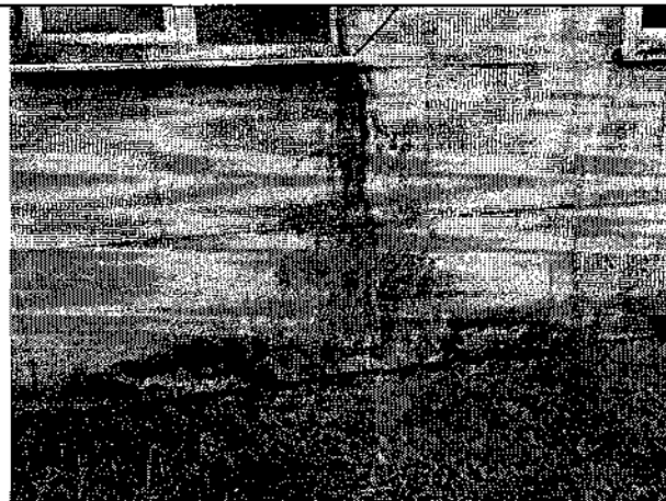
Фото 10, 11. Вымывание отделочного покрытия (цементной штукатурки) у основания цоколя, что не соответствует требованиям раздела 4 СП 71.13330.2011 «Изоляционные и отделочные покрытия».
